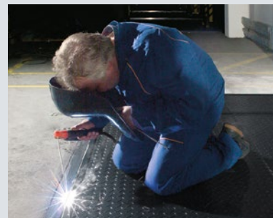
Приварить к краевым уголкам – конструкция готова.
